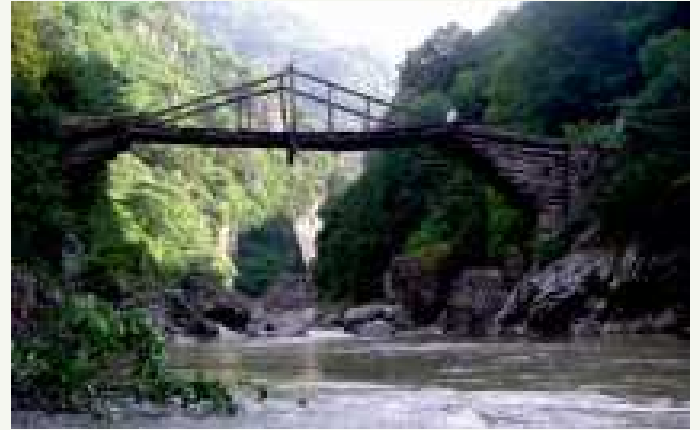
Mesudiye-Kabadüz Başkotanı Köprüsü
