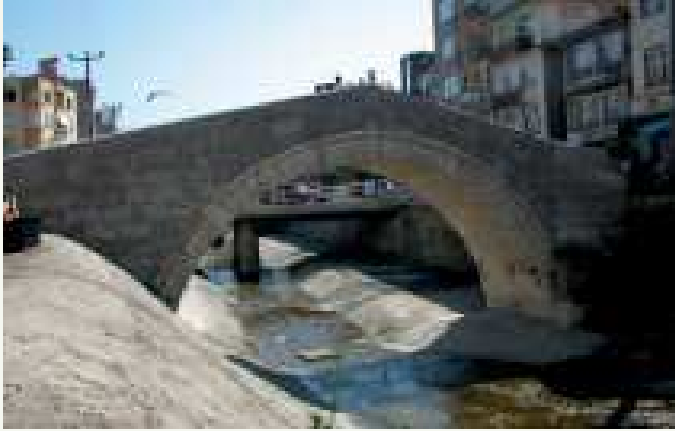
Altınordu Kemer Köprü
