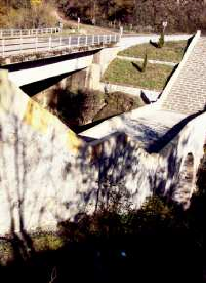
Ulubey Sarpdere Köprüsü
